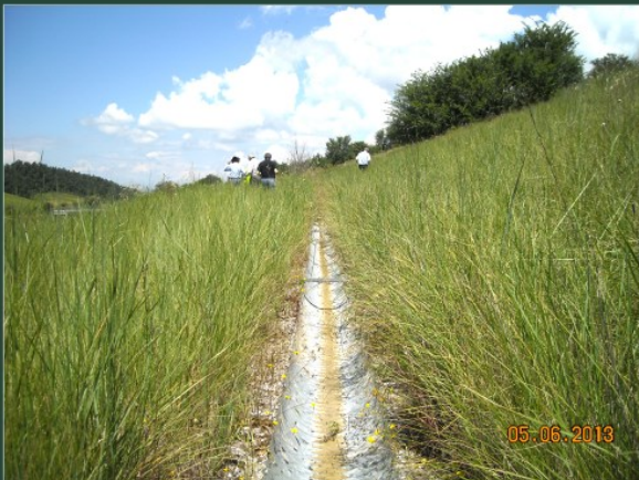
I pendii protetti dai PRATI ARMATI® non hanno mostrato segni di erosione: le canaline sono perfettamente pulite e non intasate dal materiale eroso
