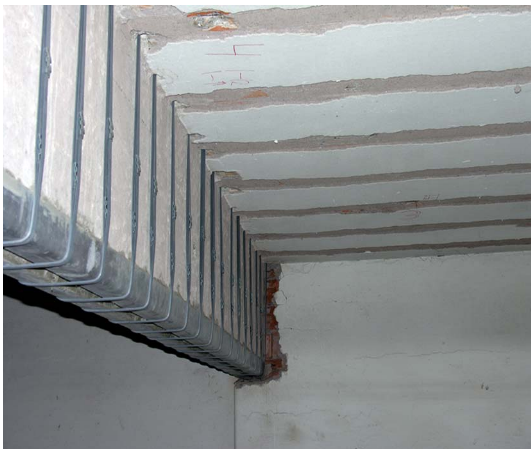
Figura 95. Rinforzo a taglio con nastri pretesi in acciaio ad alta resistenza contrastati su piastre imbutite all'intradosso del solaio
