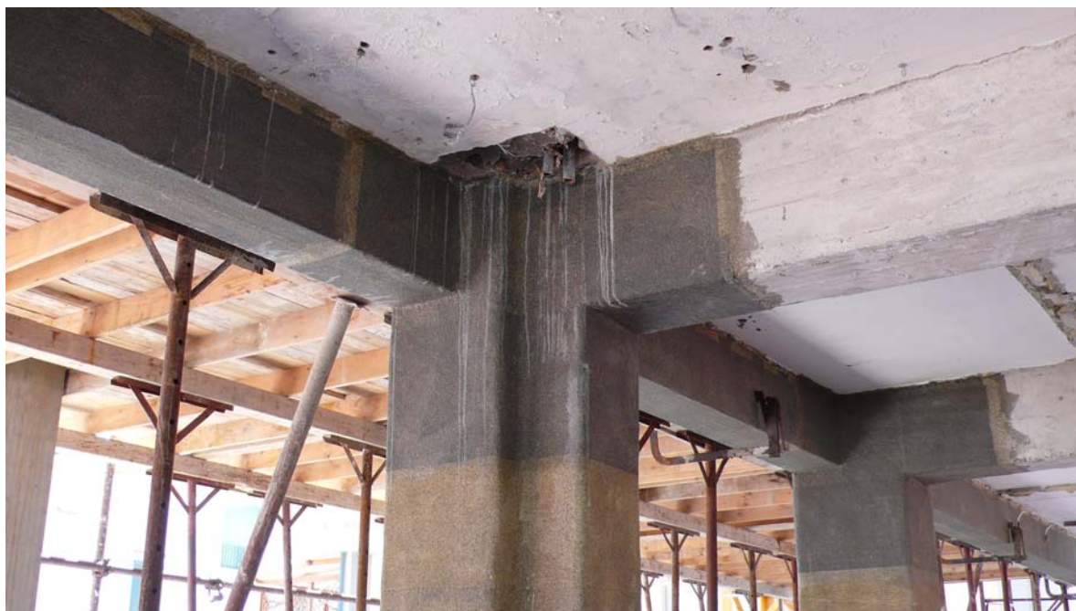
Figura 91. Rinforzo a taglio continuo con compositi di una trave interna in c.a. con fioccatore di ancoraggio
