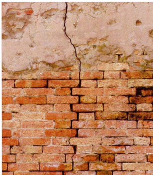
Figura 74. Paramento murario danneggiato su cui verrà realizzato intervento di scuci e cucì
