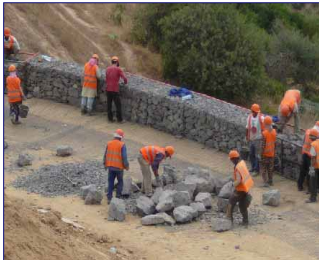
Spaccare massi sopra i rinforzi...
