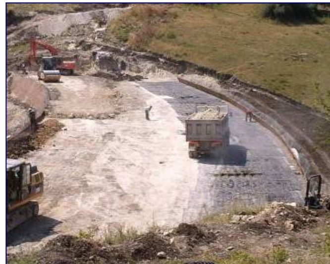
Transitare con i veicoli sopra i rinforzi...
