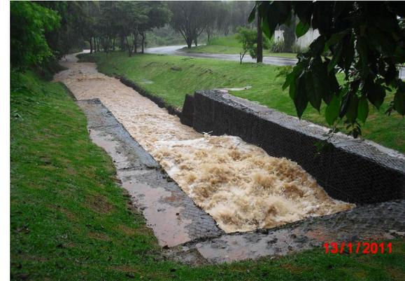
Le gabbionate sono strutture permeabili, resistenti e allo stesso tempo molto flessibili, in grado di sopportare agevolmente deformazioni dei singoli elementi, assestamenti e/o cedimenti del piano di posa o del terreno a tergo dovuti.
