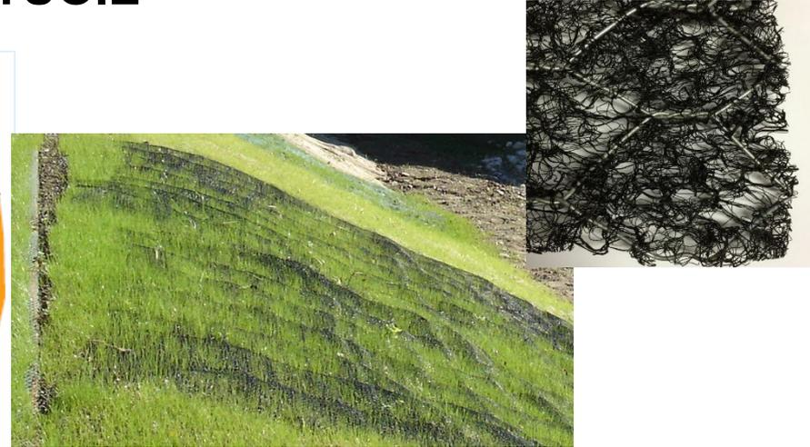
Rivestimento di sponde soggette a erosione mediante la stesa di una stuoia sintetica tridimensionale, spessore min. 10 mm, eventualmente rinforzate da una rete metallica a doppia torsione.
