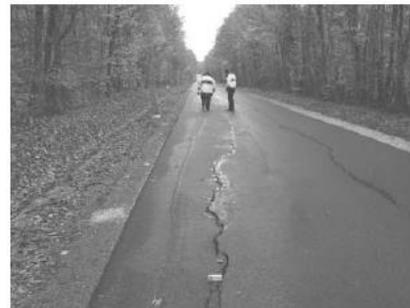
Figure 1. Fissuration longitudinale (fissure d'adaptation)
