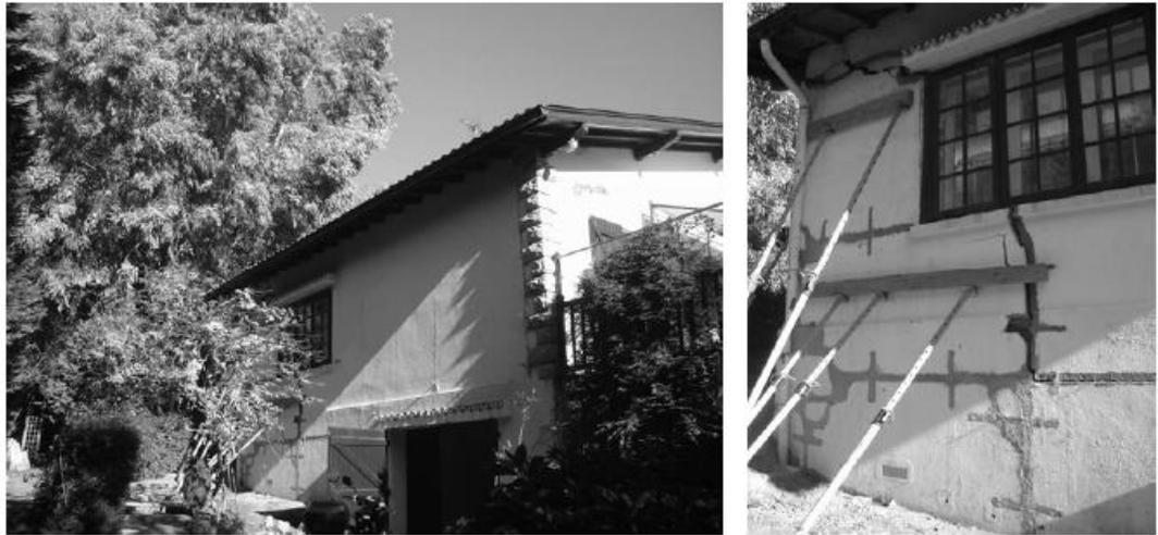
Figure 8. L'angle de la maison bascule l'été suivant la reprise en sous-œuvre générale du fait de la succion profonde et radiale des racines d'un eucalyptus
